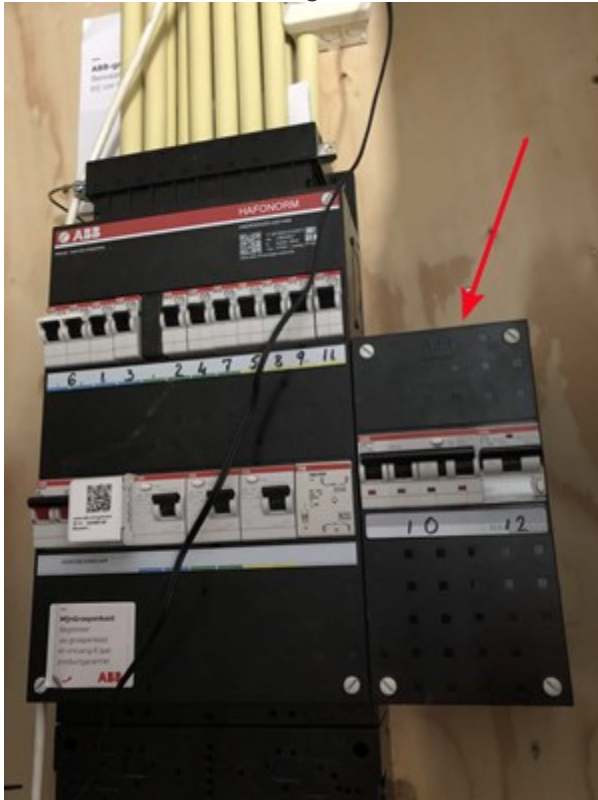
Afb. 15.1 Extra groepen in meterkast voor het PV-systeem
