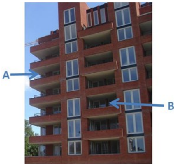
Afb. 16.8 Woning A heeft een overstek en een zijbelemmering, woning B heeft een overstek en twee zijbelemmeringen
