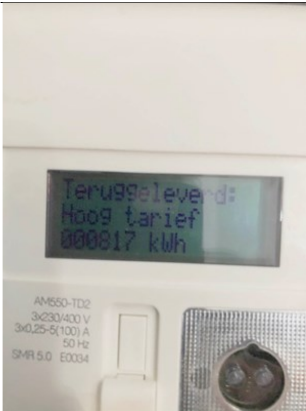
Afb. 15.2 Teruglevering van zonnestroom aan het elektriciteitsnetwerk
