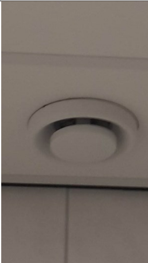
Afb. 11.7 Een afzuigventiel van mechanische ventilatie
