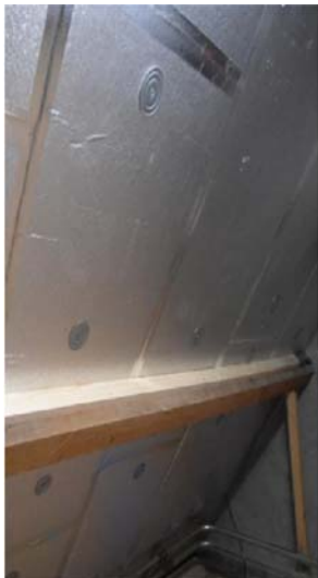
Afb. 6 Isolatie op vliering tussen de gordingen
